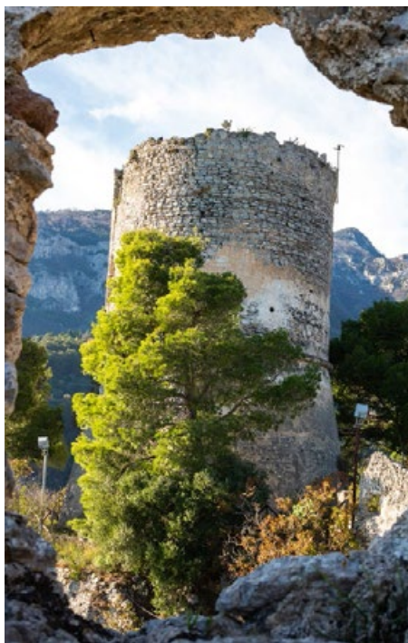
▲ Wieża Torre dello Ziro
